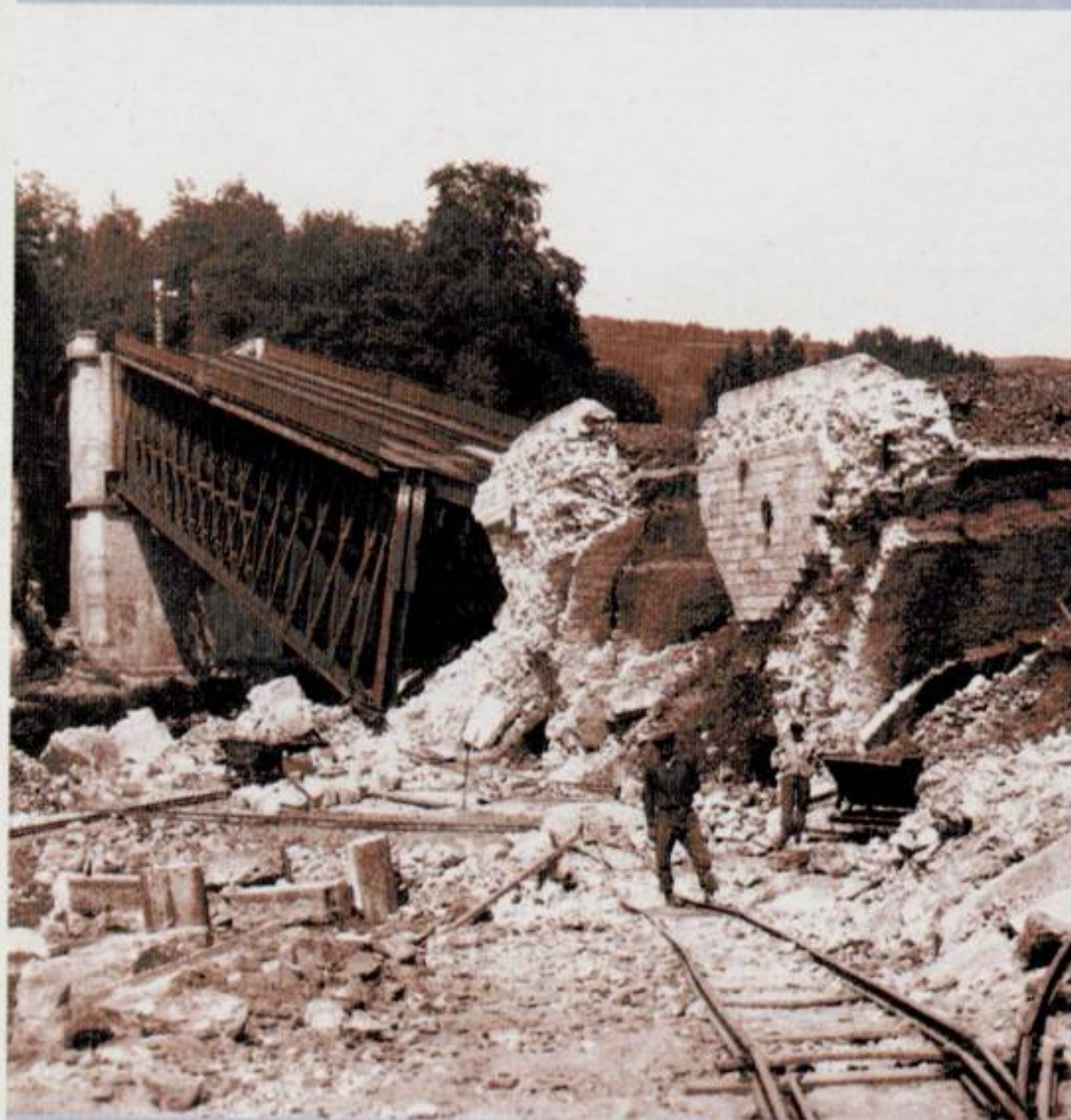
Brug opgeblazen door verzetsstrijders van de spoorwegen nabij Remouchamps. Foto: F. Lemaire - Aywaille.
