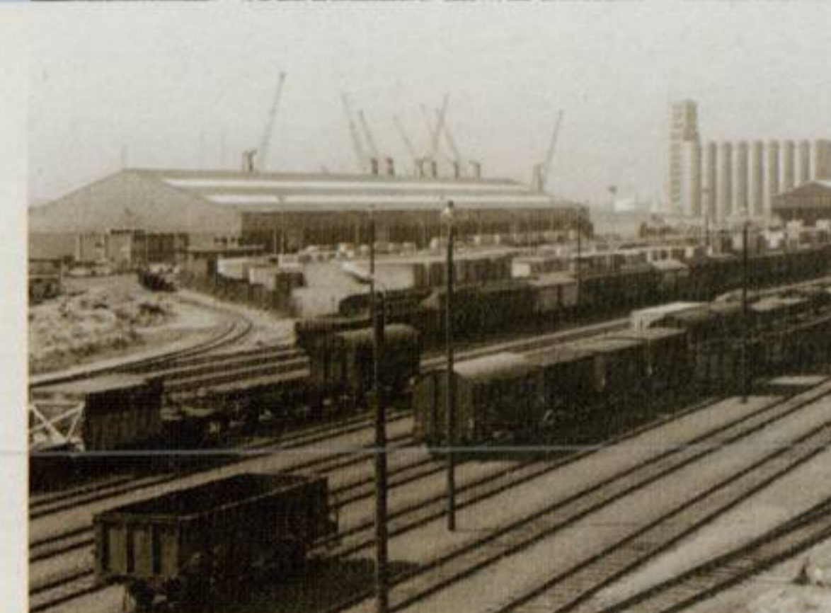
Spoorinfrastructuur in de Antwerpse haven.
